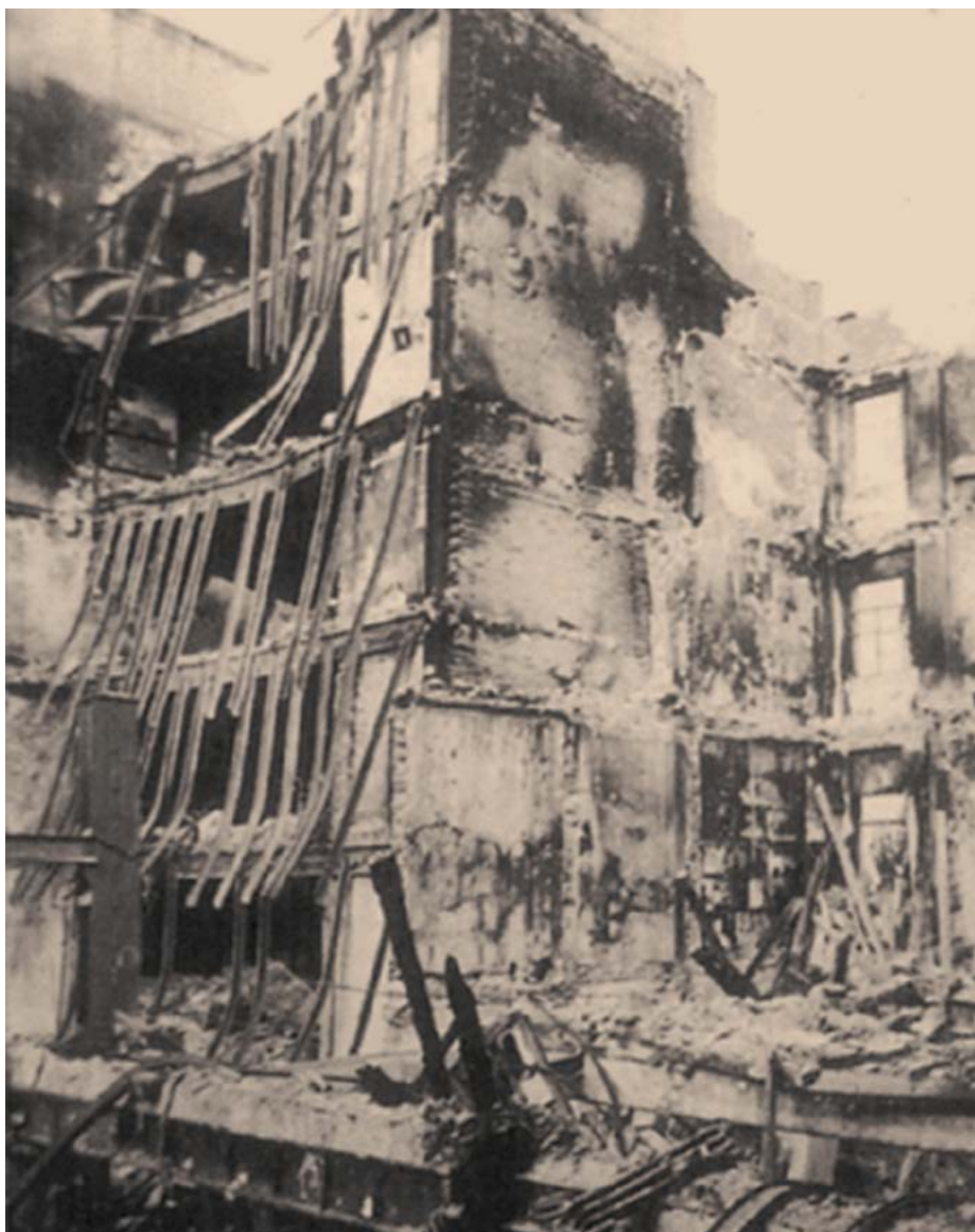
Incendi edifici Saldos Arias (Madrid – 1987). Part de l'antiga estructura de fusta de l'edifici s'havia substituït per perfils d'acer en reformes anteriors. La part que mantenia l'estructura de fusta va a quedar en peu. Victimes: 10 bombers. Font: Madera y fuego. Cátedra Madera. Universidad de Navarra.
