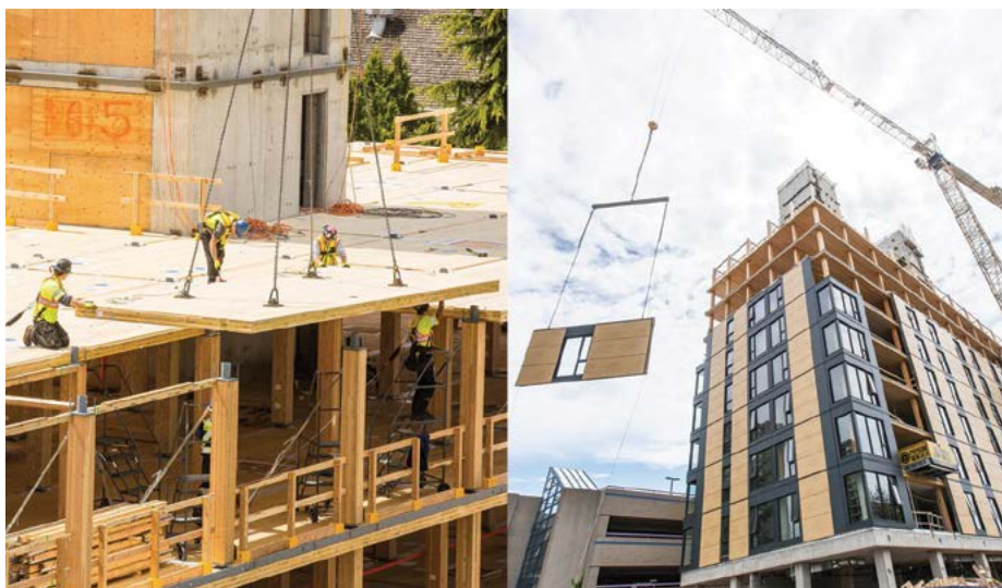
Brock Commons Tallwood House. UBC, Vancouver campus. Acton Ostry Architects Inc. Actualment, l'edifici més alt del món amb estructura de fusta (18 plantes). Fotos: maisons-bois.com
