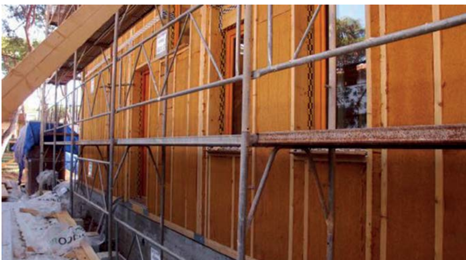
Muntatge de l'estructura amb entramat lleuger de fusta i de l'aïllament tèrmic de façana, respectivament. Fotos: House Habitat
